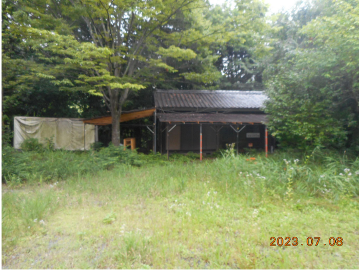
管理棟前、作業着手前の様子
