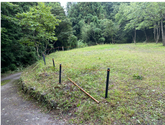
転落防止柵 2m間隔の設置後
