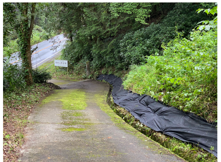
進入路の清掃作業後、防草シートを敷設
